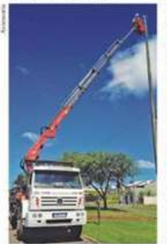
Caminhão Munkk no serviço de manutenção das lâmpadas.
